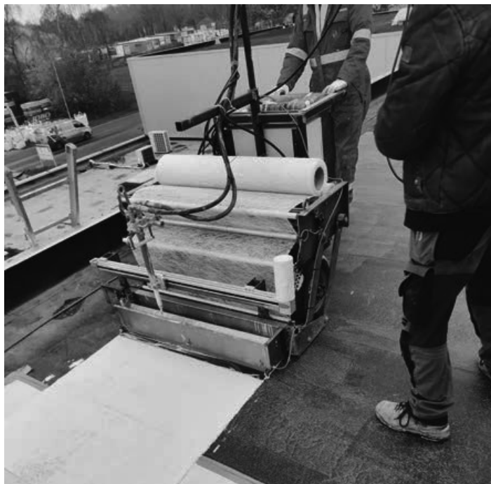
▲ Aanbrengen AllShield Blue coating met een speciaal door AllShield ontwikkelde coatingsrobot.
