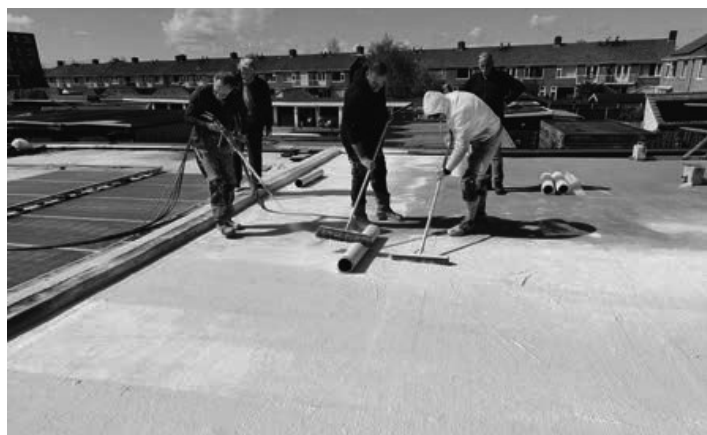
▼ Handmatig aanbrengen van de AllShield Blue-coating.
